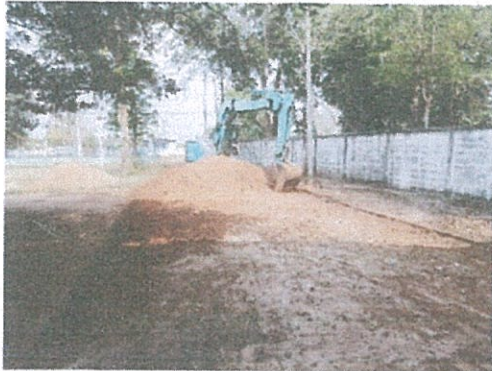
เทพื้นคอนกรีตเสริมเหล็กทางเข้าศูนย์พัฒนาเด็กเล็กลาดตะเคียน
